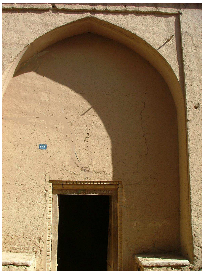
« Maison de Kasra », Yazd
