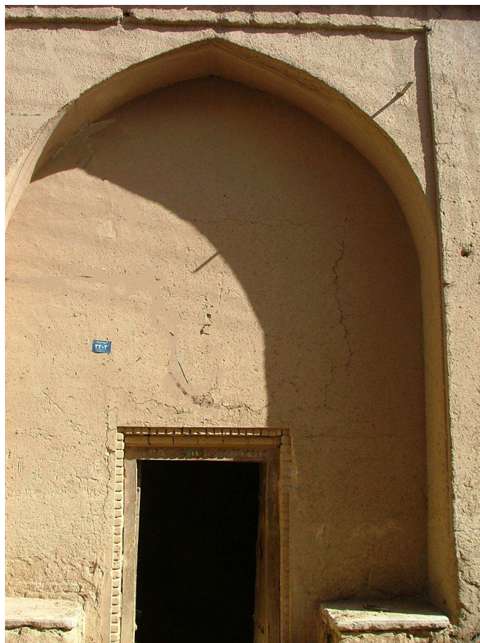
« Maison de Kasra », Yazd
